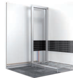
ETAPE 2 DÉPOSE BAIGNOIRE ET INSTALLATION STRUCTURE LÉGÈRE
